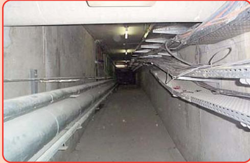
Galerie de câble
